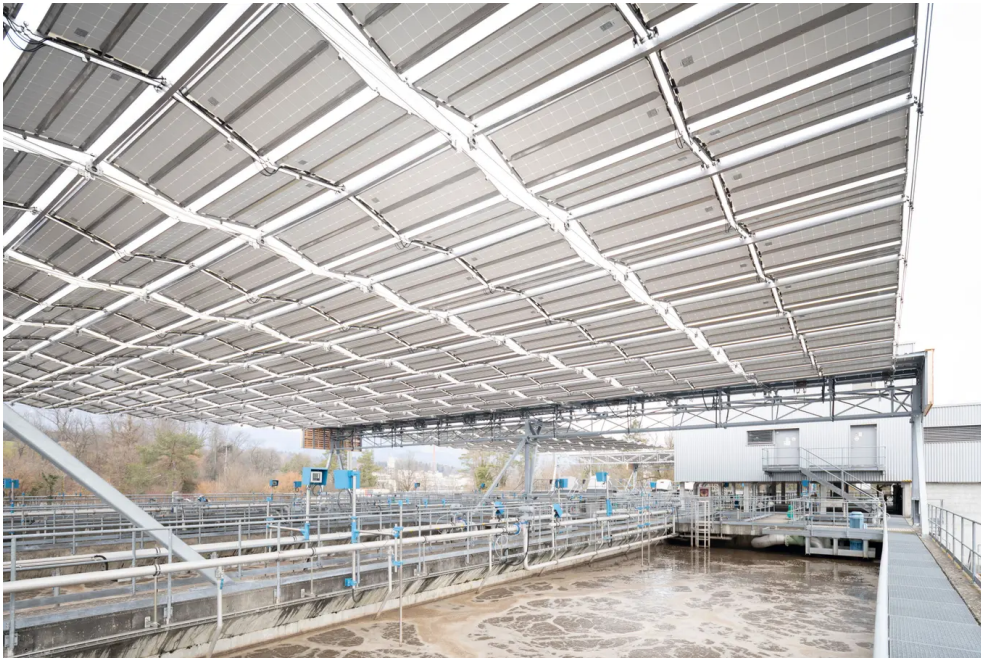
Das Solarfaltdach über den grossen Klärbecken in Zuchwil.
