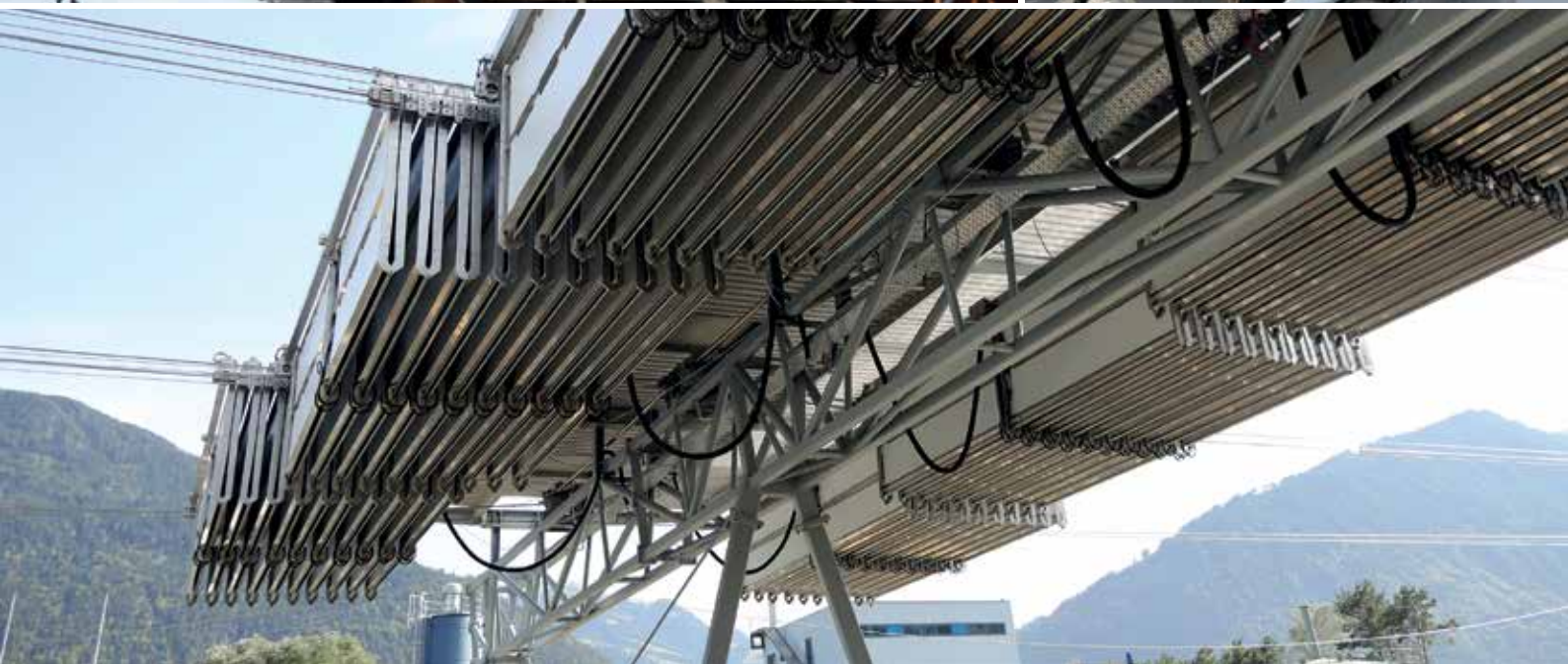
Das weltweit erste Solarfaltdach Horizon fährt die einzelnen Elemente je nach Wetter automatisch ein und aus. Das Faltsystem basiert auf Seilbahntechnik.
